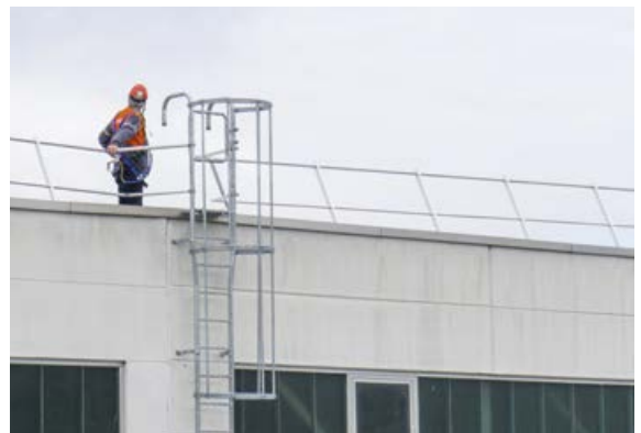
Geländer und Leitern mit Rücken- und Seitenschutz sorgen für Sicherheit
