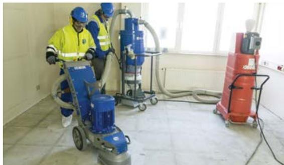
Vorne wird geschliffen und aufgesaugt, hinten der Staub gefiltert und die Asbestfasern abgeschieden
