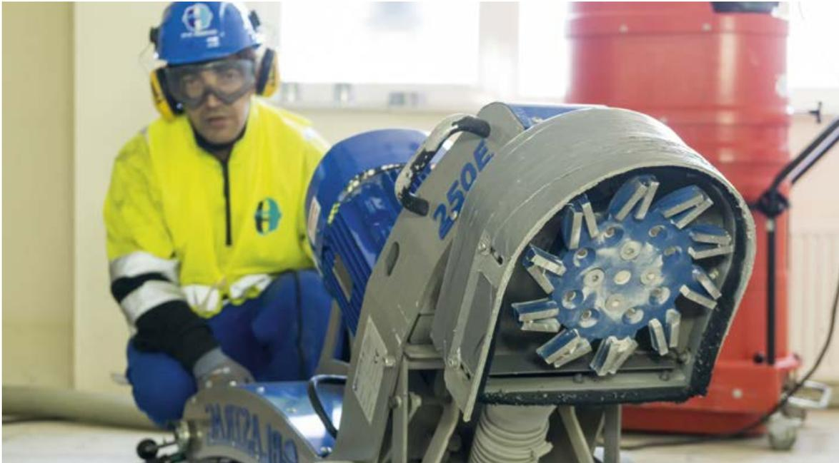
Das „Herzog-Schleifverfahren“: Mit dieser Maschine wird der asbestbelastete Fußbodenkleber abgeschliffen, und die Asbestfasern werden direkt aufgesaugt
