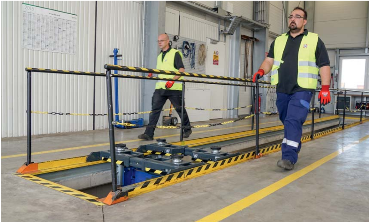
TIP Trailer Services: Die Grube mit hochgeklappter Absturzsicherung
